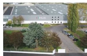
Usine de Feuquières-en-Vimeu
