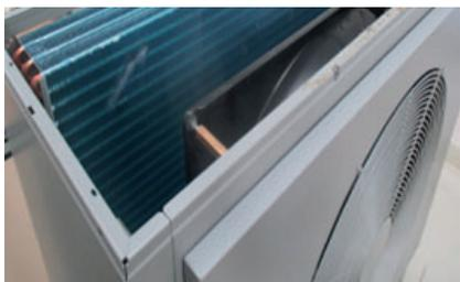
**Étape 2 :** Retirer le panneau de support de la grille du ventilateur en ôtant les 2 vis situées sous le panneau de part et d'autre du ventilateur à l'aide d'un tournevis Torx T20, puis faire glisser le panneau vers le haut pour la dépose de celui-ci.
