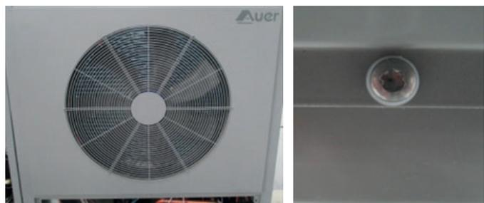
**Étape 3 :** Les écrous servant au maintien des entretoises sont maintenant visibles. Les desserrer à l'aide d'une clé de 13. (Veiller à ce que le ventilateur ne bascule pas à l'intérieur de la machine).
